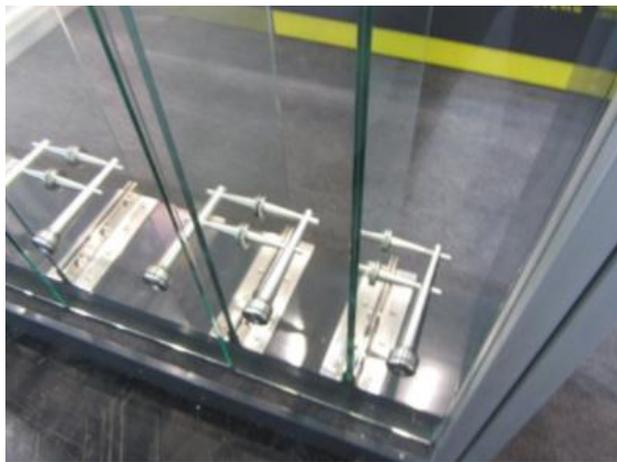
Рисунок 1 – Пример соединения металлическими фитингами стеклянных элементов систем планарного остекления между собой [9]
