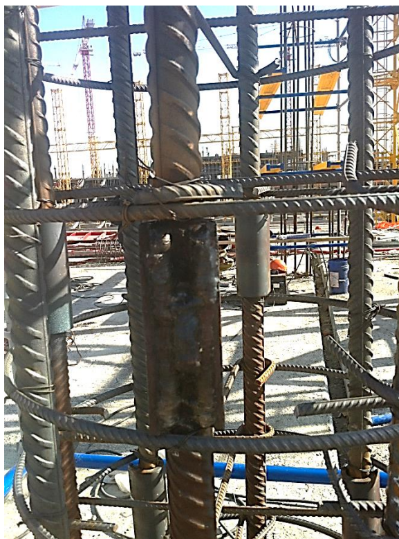
Рисунок 1 – Арматура сборной железобетонной конструкции
