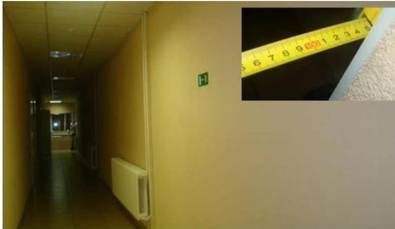
Рис.12 – Общий вид коридора в осях «26-30» между рядами «Д-Е»
