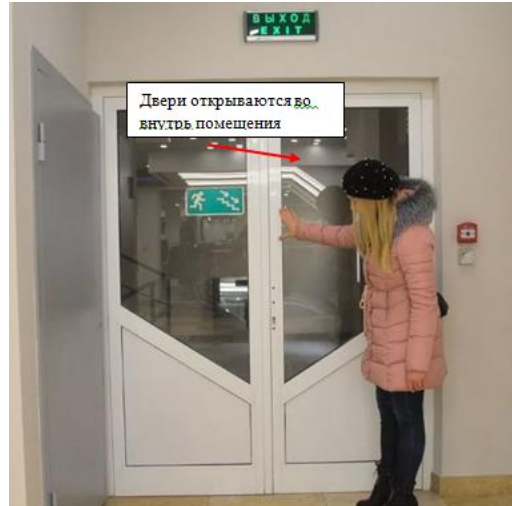
Рис. 11 – Общий вид двери, ведущей на лестничную клетку фитнес-центра
