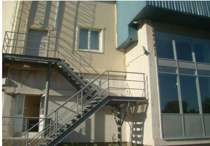
Рис. 7 – Общий вид наружной лестницы ведущей из административной части блока
