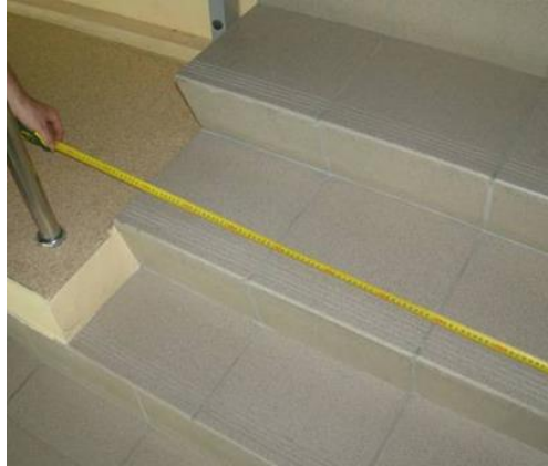
Рис. 4 – Замер ширины лестниц ведущих с трибун
