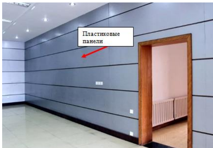
Рис. 9 – Общий вид стены коридора в осях «32-40», между рядами «Е-Ж»
