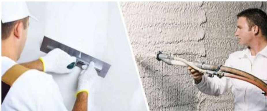
Рис. 1 Ручной и механизированный способы нанесения штукатурной смеси на поверхности.
